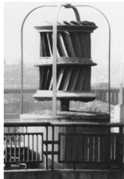
Původní Francisova turbína vodní elektrárny Štvanice
