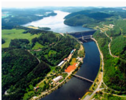
Vodní elektrárna Orlik
