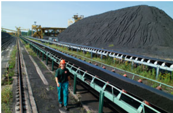
Skládka uhlí v Elektrárně Dětmarovice
