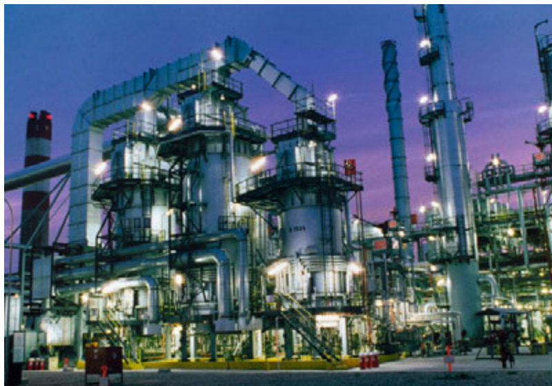
Rafinerie v noci
