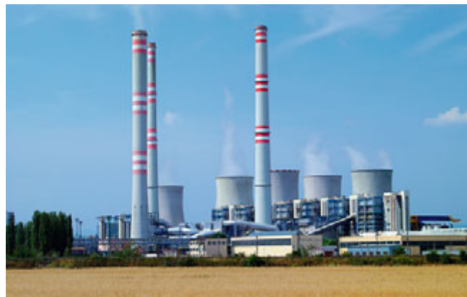
Odsířená Elektrárna Počerady
