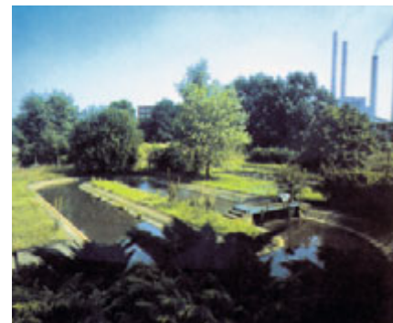
Biologická čistírna vody v Elektrárně Mělník
