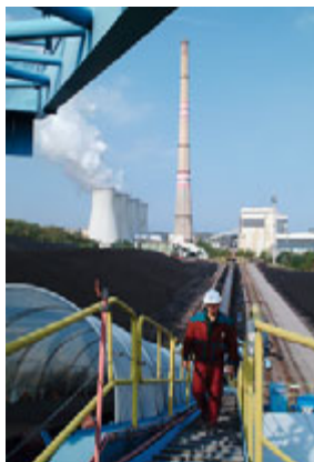
Skládka uhlí v Elektrárně Chvaletice
