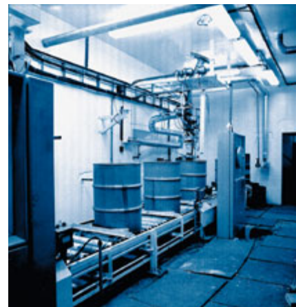
Linka na zpracování odpadů v dukovanské elektrárně
