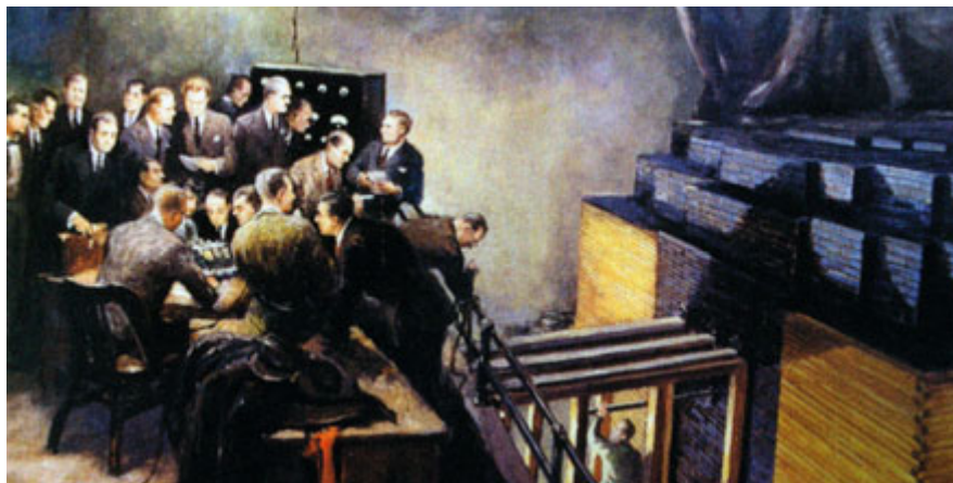
Regulační tyč, balón zavěšený pod stropem v roli ochranné obálky, termometr s radiolampami a detektor neutronů na kresbě znázorňující spuštění prvního atomového reaktoru světa ve sklepení Stagg Fieldu 2. 12. 1942 nejnáznorněji ilustrují primitivní zárodky „jaderné bezpečnosti“
