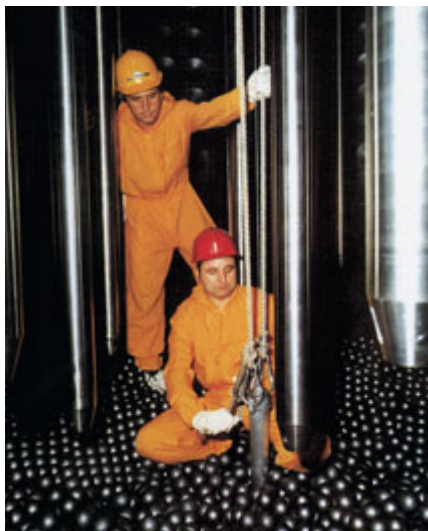
Pohled do reaktoru demonstrační elektrárny HTR-300
