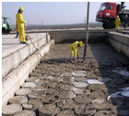
Betonáž na úložišti v Dukovanech
