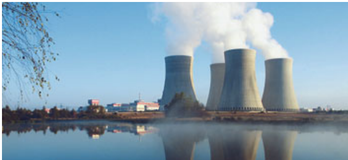
Jaderná elektrárna Temelin
