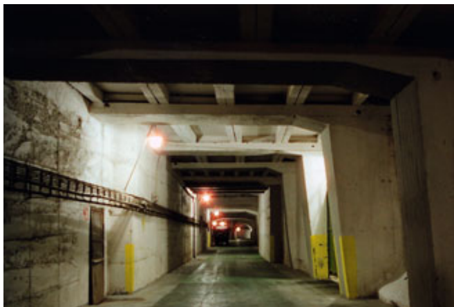
Dopravní chodba úložiště Richard
