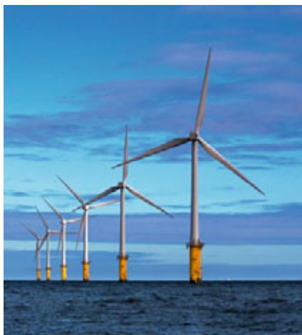
Větrné elektrárny najdeme i na mořské hladině, kde existují vhodné podmínky pro využití větrné energie. Na snímku je dánská tzv. offshore větrná farma nedaleko Kodaně disponující 20 větrnými jednotkami i jednotkovém instalovaném výkonu 2 MW. Údajně první větrnou elektrárnou na světě, stojící od roku 1990 na mořské plošině, je elektrárna Svante 1. Při výkonu 200 kW má dodávat 500 000 kWh ročně pro 125 domácností bez elektrického vytápění u švédského „větrného“ ostrova Oland.
