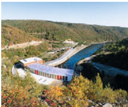
Vodní elektrárna Dalešice
