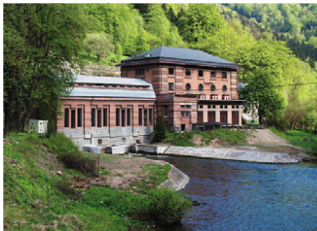
Vodní elektrárna Spálov
